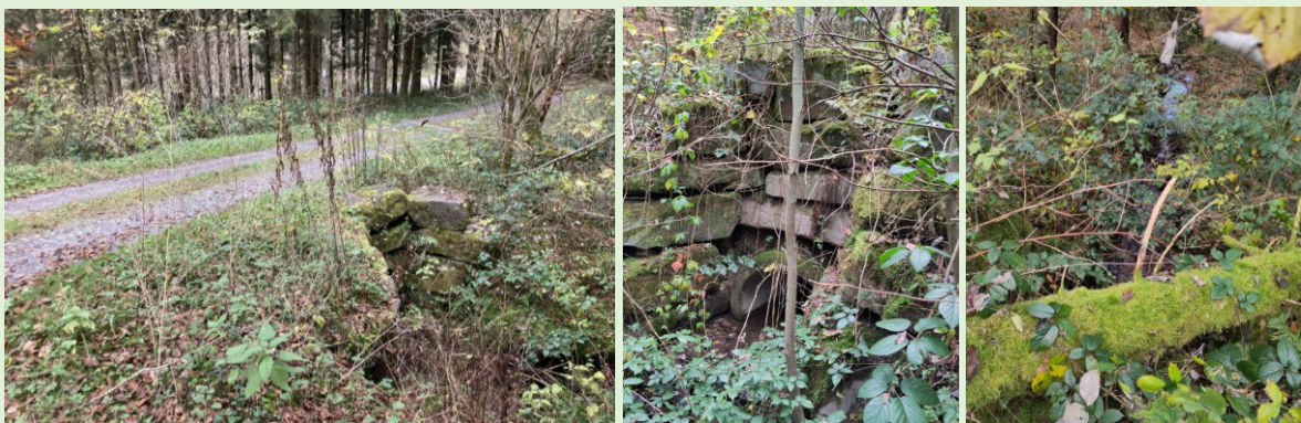
Verrohrung unter dem Waldweg, Rohreingang oberhalb, Bachlauf unterhalb. Quelle: eigene Fotos
