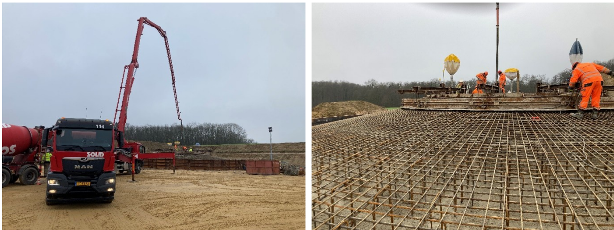
Abbildung 5: Beispielbilder von Betonierungsarbeiten für das Fundament der WEA Beckerich. Quelle: Oeko-Bureau, 2024
